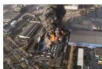
Brand bij Chemi-Pack te Moerdijk, 5 jan 2011 Foutieve handeling correctief onderhoud Bron: www.onderzoekraad.nl
